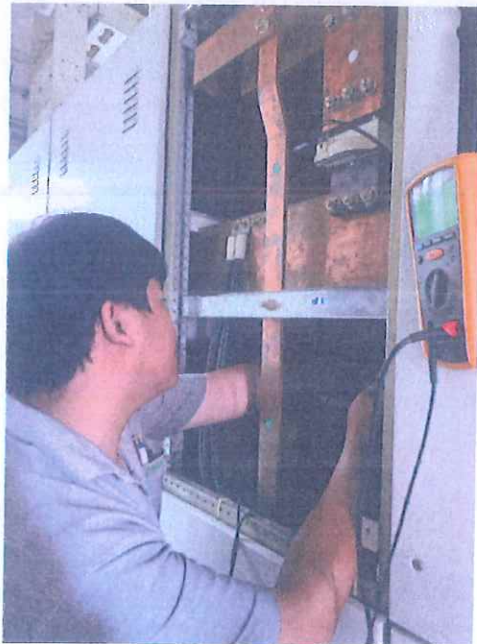
ภาพชุดที่ 16 ขณะดำเนินการตรวจสอบสภาพฉนวนไฟฟ้าภายในตู้ MDB เพื่อบันทึกข้อมูลและความปลอดภัยก่อนจ่ายไฟกลับคืน
