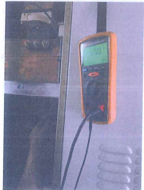
ภาพชุดที่ 16 ขณะดำเนินการตรวจสอบสภาพฉนวนไฟฟ้าภายในตู้ MDB เพื่อบันทึกข้อมูลและความปลอดภัยก่อนจ่ายไฟกลับคืน
