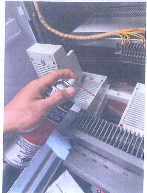
ภาพชุดที่ 10 ขณะดำเนินการทำความสะอาดและฉีดน้ำยาทำความสะอาดหน้าสัมผัส และ รางดีบอาร์คของ ACB เพื่อยืดอายุการใช้งาน
